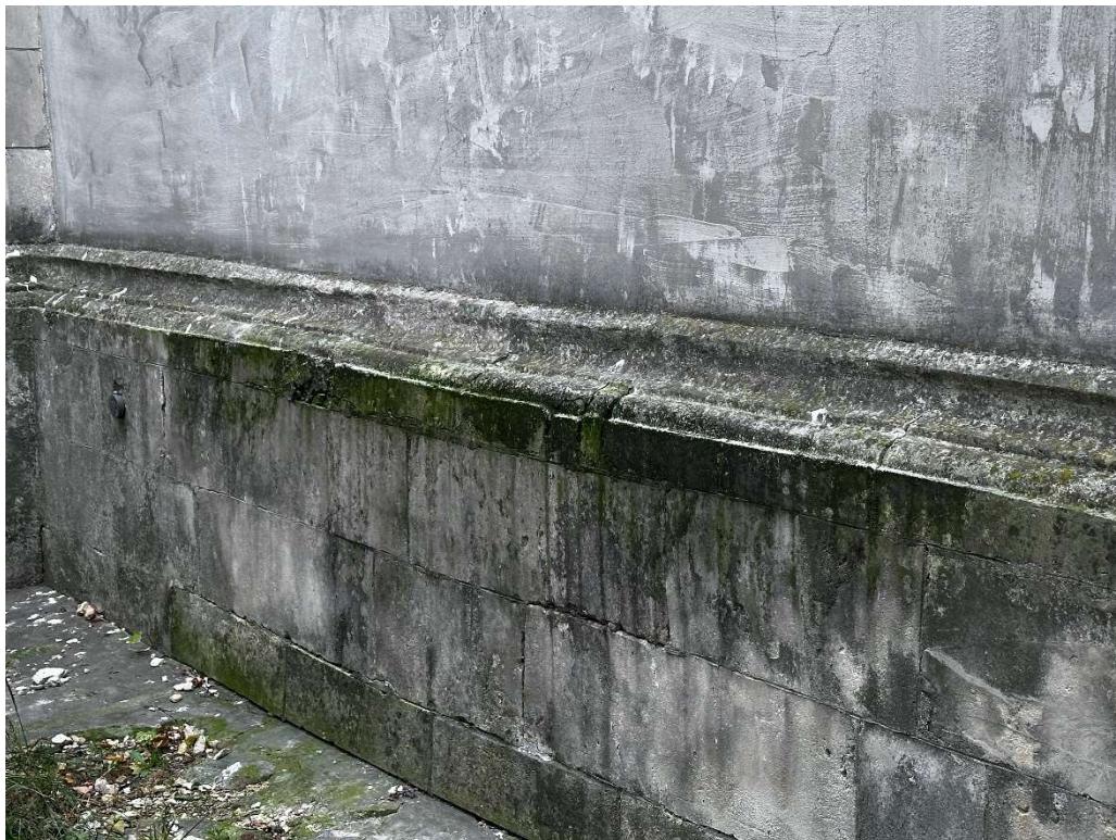
Fot. nr 9 XVII kościół p.w. Nawiedzenia NMP zespołu klasztornego OO. Franciszkanów w Pińczowie. Widok porażenia mikrobiologicznego kamiennego cokołu elewacji frontowej
